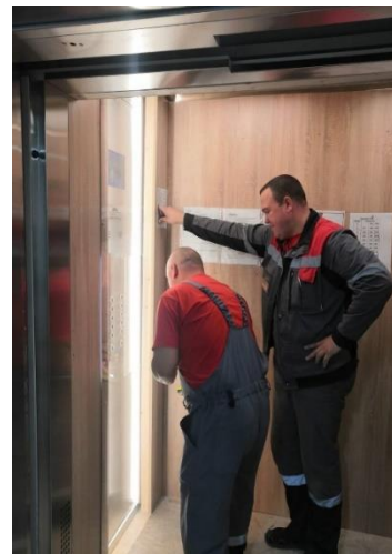
Установили обшивку приказных панелей лифтового оборудования Петровский пр., д. 11, корп. 3
